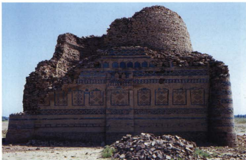
Pl. 1 Bau 1: Ost-Fassade (oben) und West-Fassade (unten).
