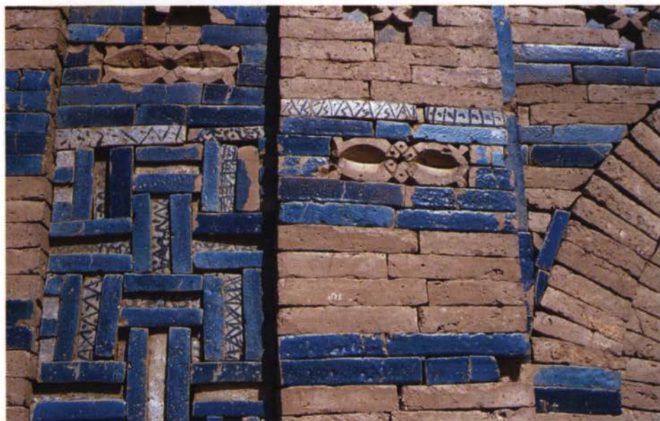
Pl. 3 Bau 1: Südportal (oben) und Südportal, Detail (unten).
