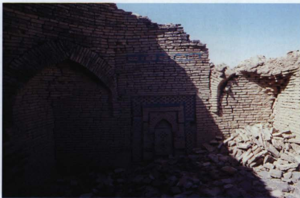
Pl. 8 Bau 3: Ost-Portal, Detail (oben) und Mihrāb (unten).
